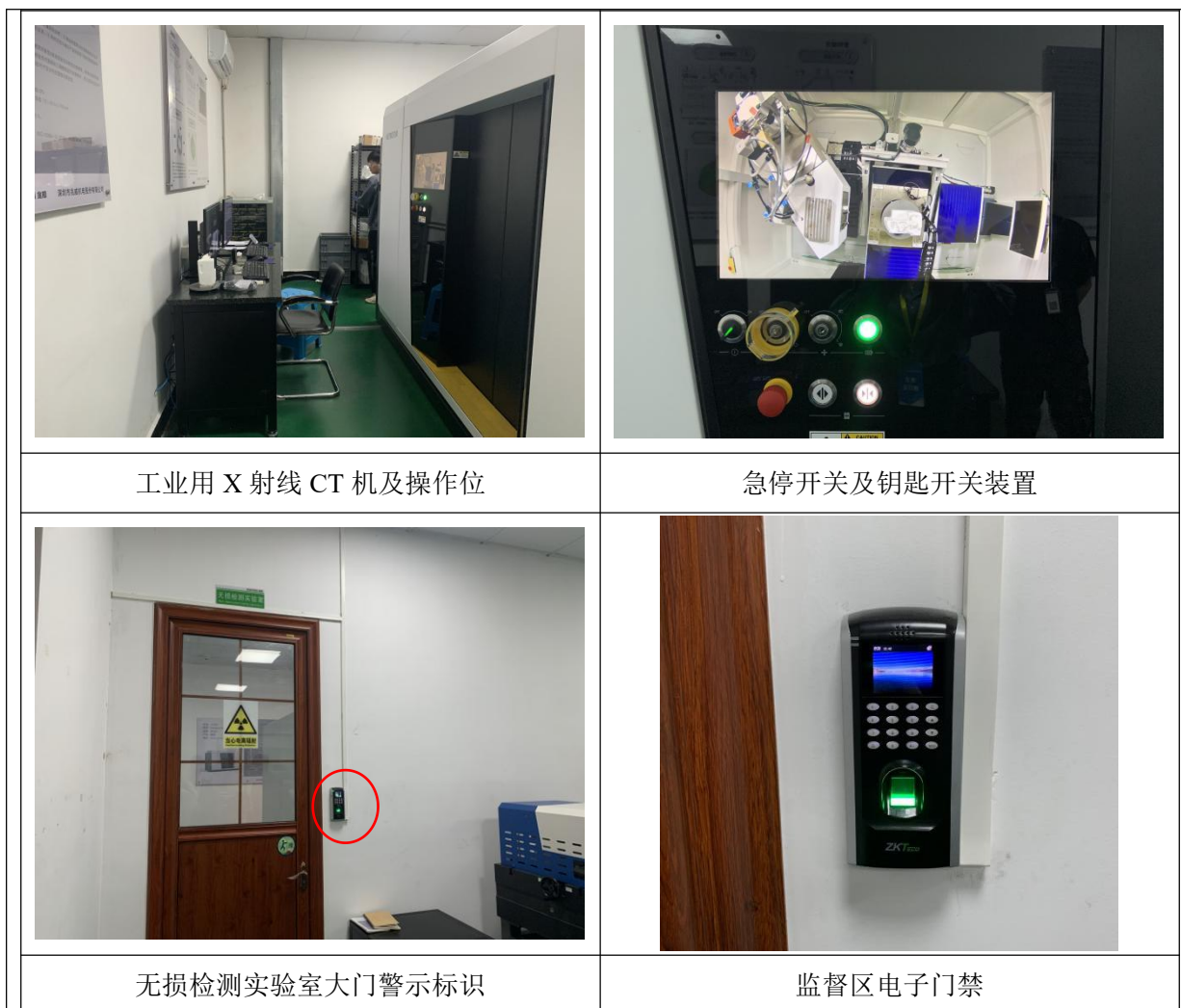
图 3-4 辐射安全防护设施
